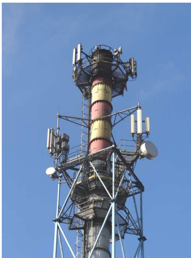
Fot.2.Anteny zawieszane aktualnie na kominie
