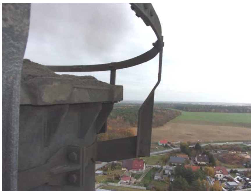
Fot.26.Głowica trzonu komina, szczytowy otok odgromowy
