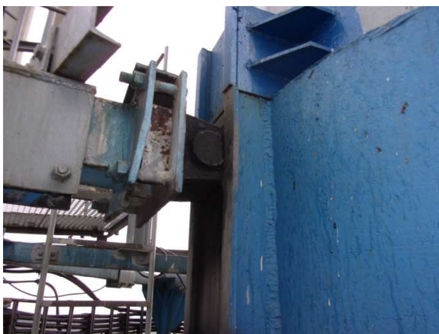
Fot.18.Rozbudowa prowadnic oporowych podpór w poziomie +47,8
