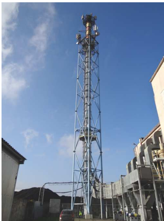
Fot.1.Widok ogólny komina
