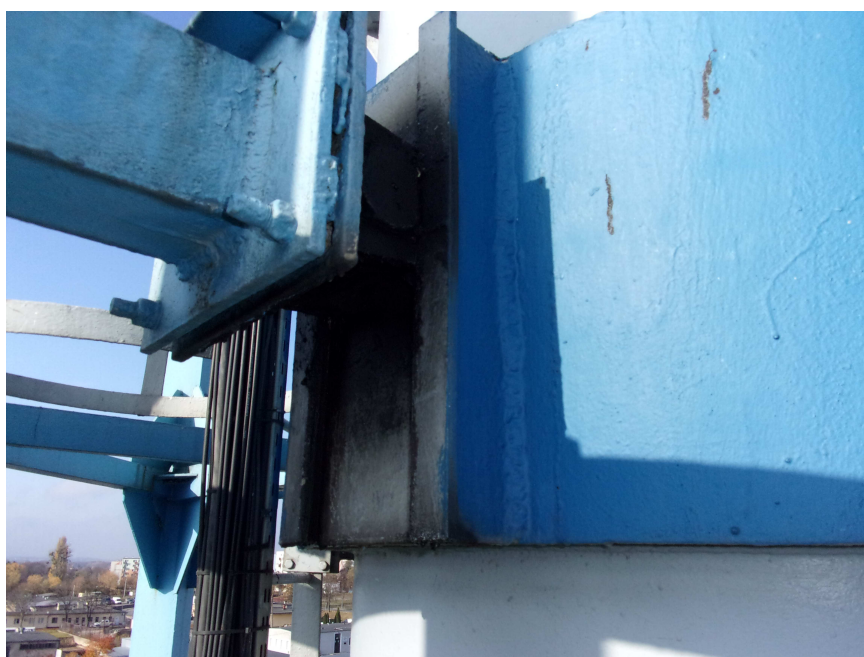
Fot.6.Podparcie trzonu komina w wieży kratowej
