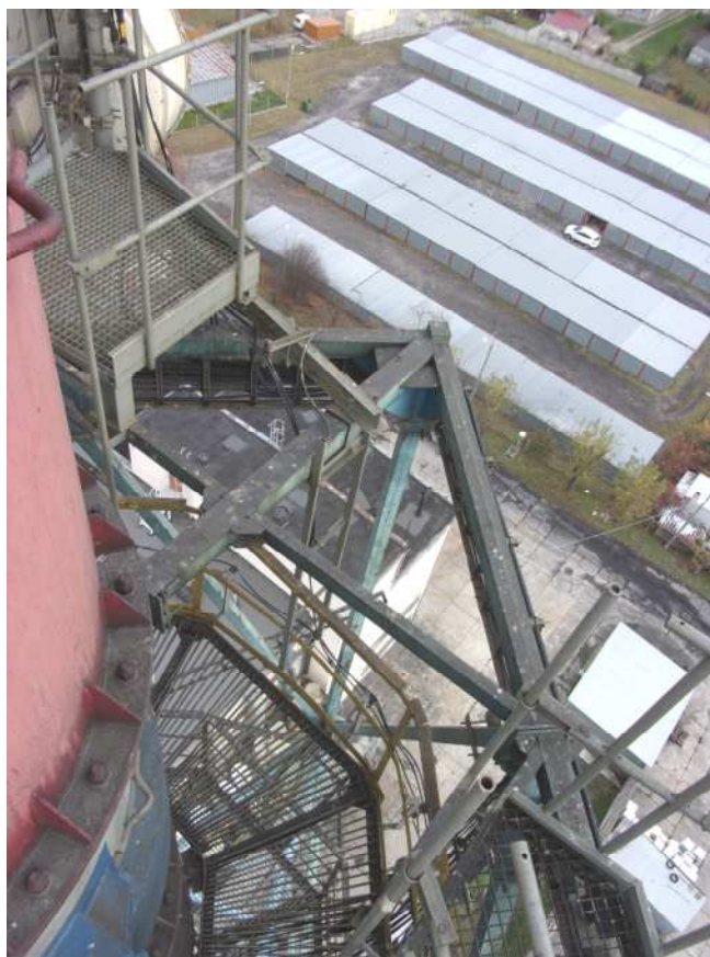
Fot.7.Pręt podporowy podpierający trzon w wieży
