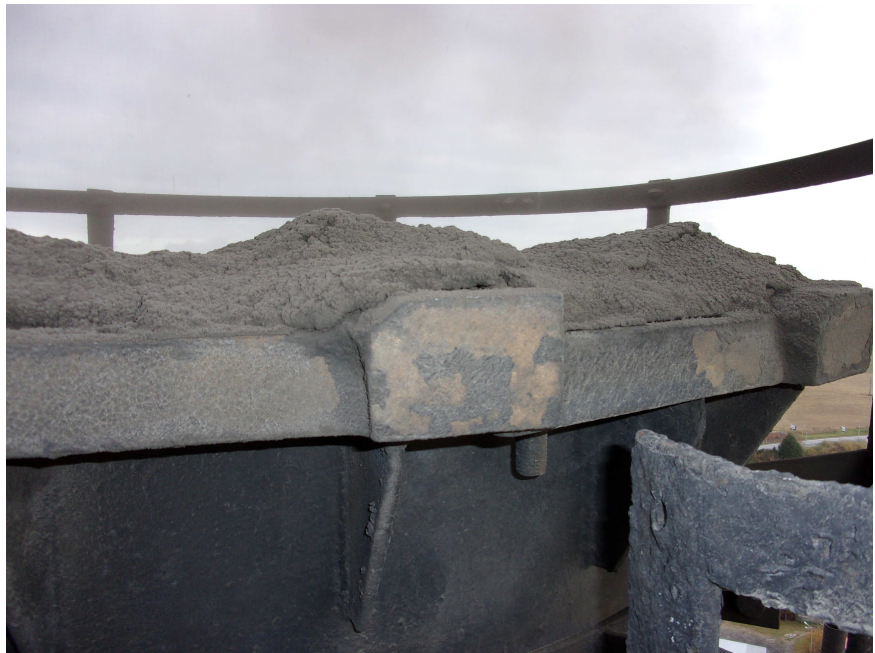
Fot.24.Głowica trzonu komina
