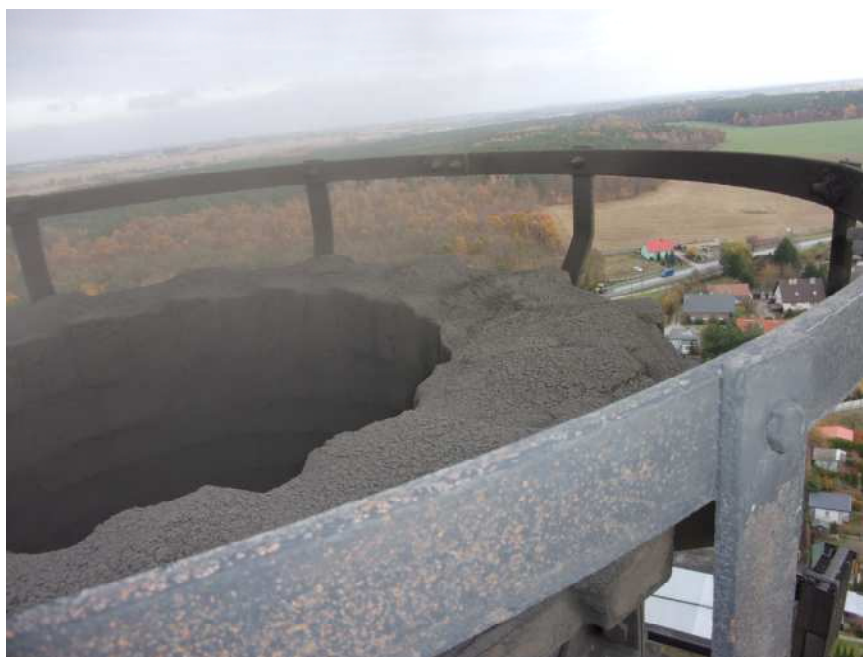
Fot.25.Głowica trzonu komina, szczytowy otok odgromowy
