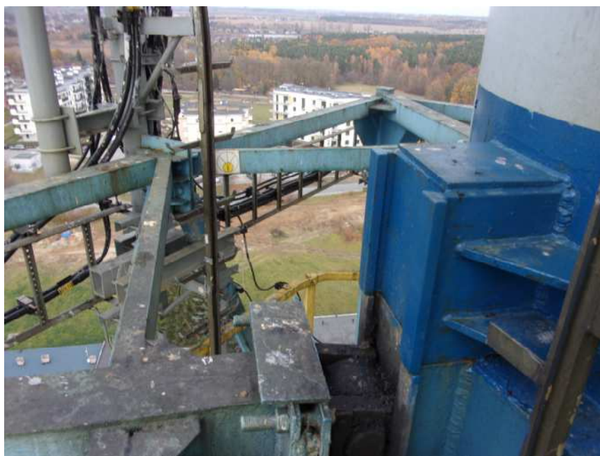
Fot.17.Rozbudowa prowadnic oporowych podpór w poziomie +47,8
