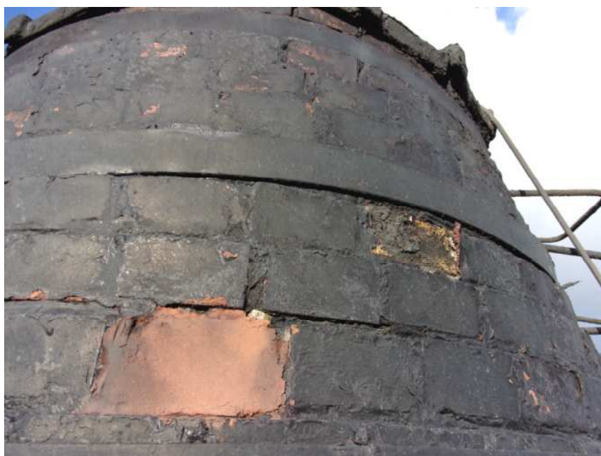
Fot.18.Zwężka ceramiczna na szczycie komina, wykonane naprawy
