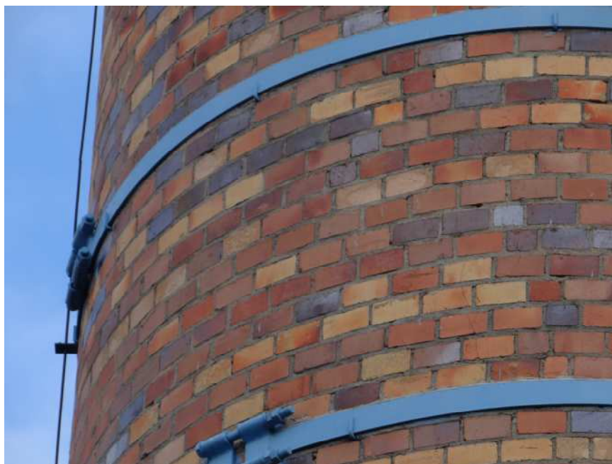
Fot.5. Wykonane naprawy trzonu komina
