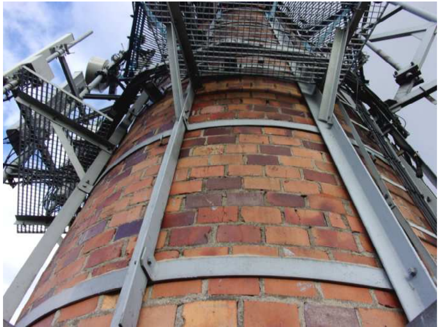
Fot.3.Krawężniki wzmacniające łączone do wsporników pomostu
