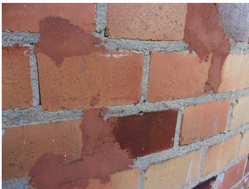
Fot.6. Wykonane naprawy trzonu komina
