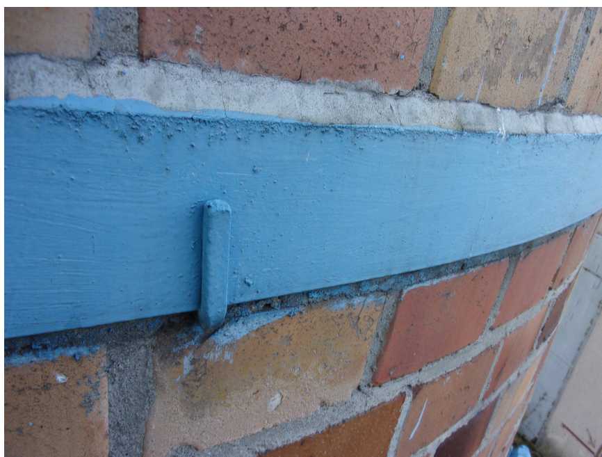
Fot.8. Obręcze stalowe, haki podpierające elementy obręczy
