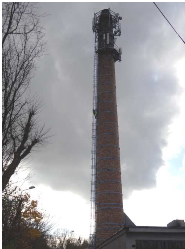
Fot.1.Widok ogólny komina
