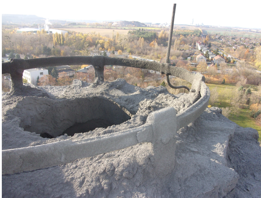
Fot.20.Podłączenie zwodu do szczytowego otoku odgromowego
