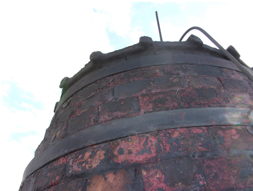
Fot.15.Zwężka ceramiczna na szczycie komina
