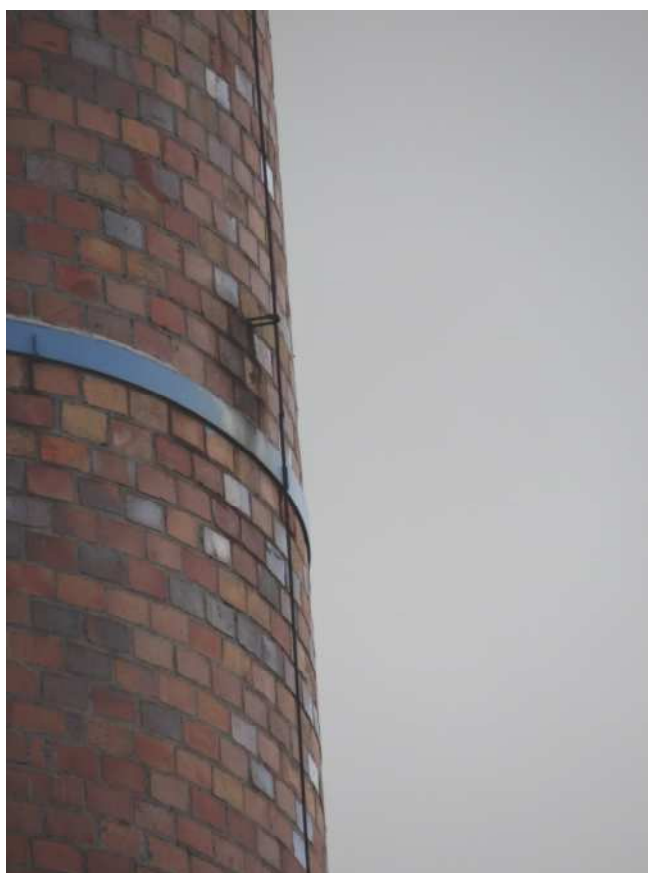
Fot.10.Korodujący pionowy zwód odgromowy
